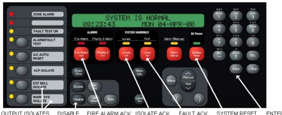
OUTPUT ISOLATES DISABLE FIRE ALARM ACK ISOLATE ACK FAULT ACK SYSTEM RESET
